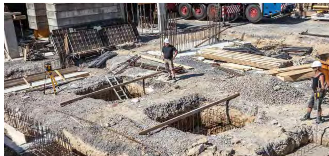
El láser convence por su fácil manejo y, en combinación con el receptor REC 300 Digital, permite trabajar con rapidez y fiabilidad en un alcance de hasta 800 m.
