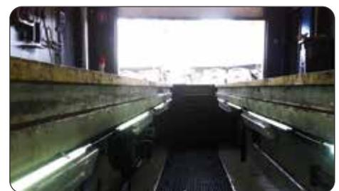
Ejemplo de la solución LINE LIGHT montada en el foso de un mecánico de camiones
